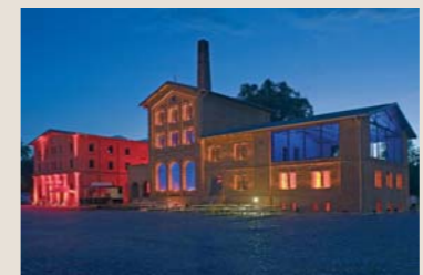
Kornspeicher (5) und Brennerei (4), Hofseite
