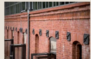
Rinderstall (2) Detail außen
